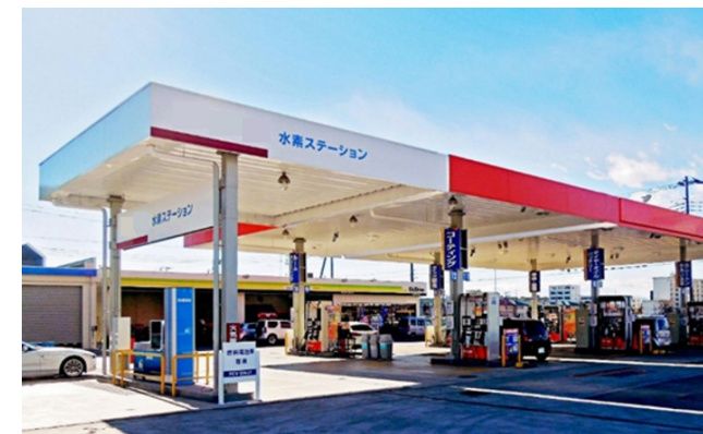
【水素ステーション】
