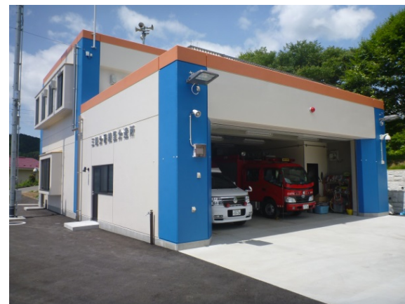
【消防庁舎復旧事業】
